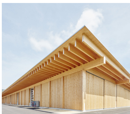
Dépôt autoroutier, Loveresse BE
