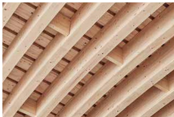
Untersicht mit Dachbinder, Kipphalterungen und Sekundärtragwerk.
