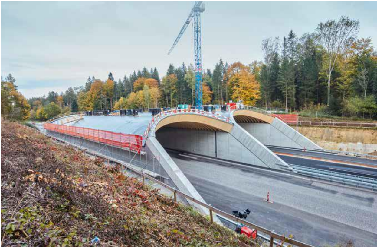
Ansicht der neuen Wildtierüberführung. Die Dachkonstruktion besteht vollständig aus Schweizer Fichte.
