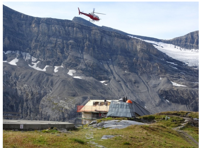
Sämtliche Elemente für die Erweiterung kamen per Heli
