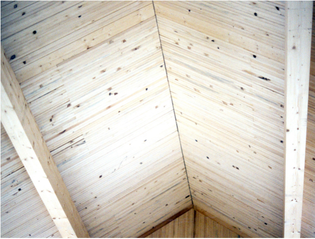
Dachkonstruktion mit optiholz-Brettstapel-Modulen
