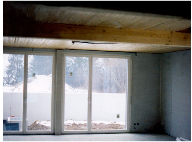
Ein Blick ins Wohnzimmer im Rohbau
