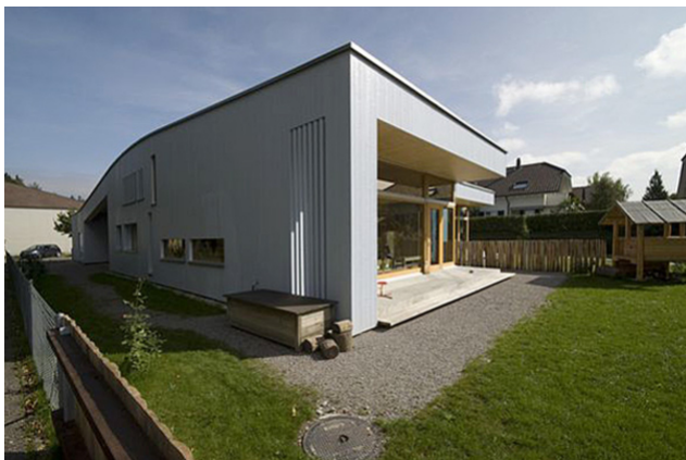
Vue extérieure côté entrée
