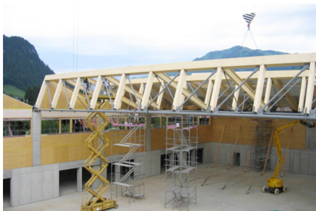
Montage de poutres en treillis
