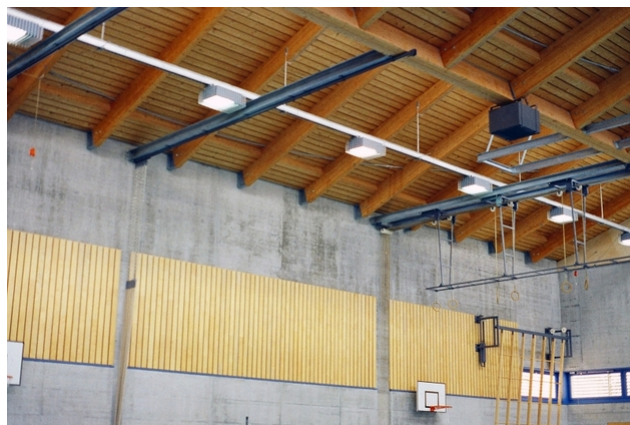
Vue de la position exposée des chevrons
