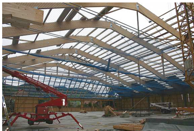
Mise en place du liant
