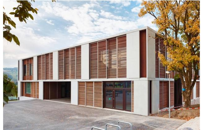
Le bois marque le quotidien des enfants de l'école Schachenmatten à Bonstetten. Le bâtiment scolaire, construit en 2015, est une construction hybride avec des plafonds en béton et des murs extérieurs porteurs en bois. L'exemple le montre : La construction en bois prend également de plus en plus d'importance dans les bâtiments publics.
