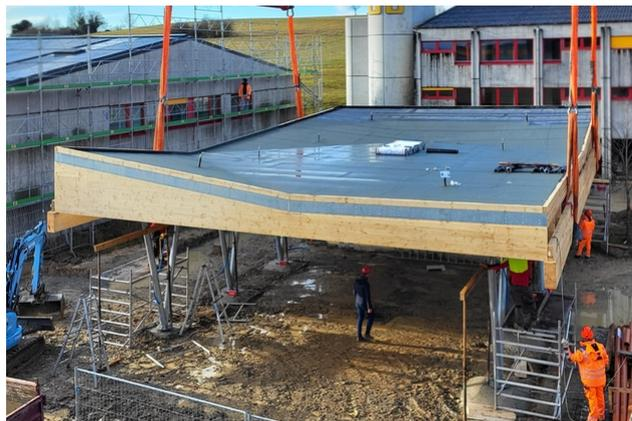
La nouvelle place de rangement et nettoyage de fin de journée sur la place de Chamblon a été réalisée avec une toiture en bois et sur le principe d'origami. Des panneaux CLT et TS3 ont rendu ce principe possible.
