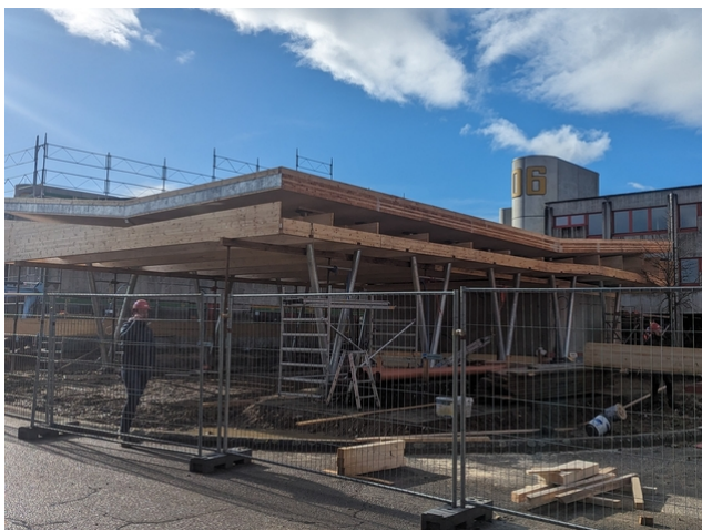
Impression du chantier
