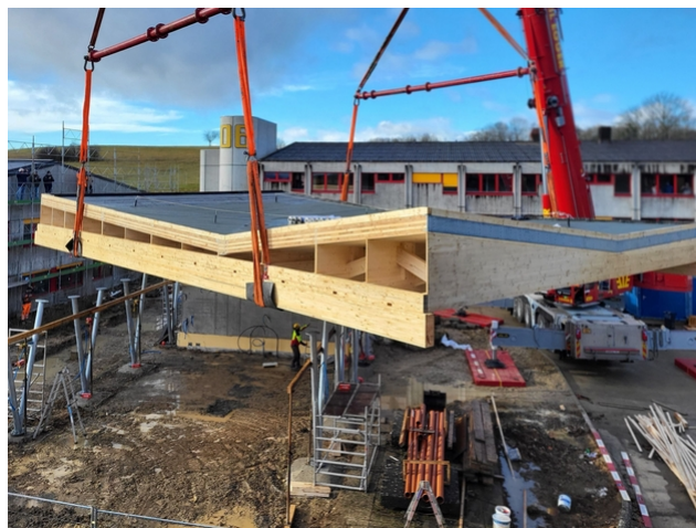
Le spectaculaire toit pliant/incliné est mis en place
