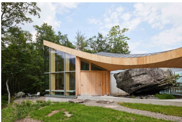
La pierre est le centre du bâtiment
