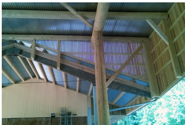
Structure porteuse dans le bâtiment fini
