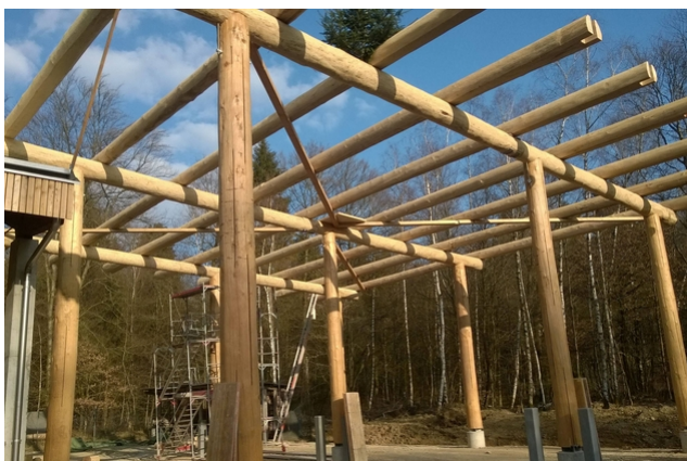
Structure porteuse après montage
