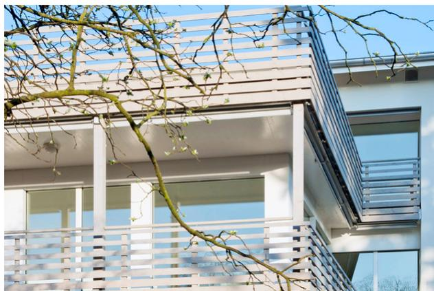
L'immeuble d'habitation existant de la Salvatorstrasse a fait l'objet d'une rénovation complète afin de créer plus d'espace, de confort et d'esthétique. L'extension de l'espace habitable est composée d'éléments en caisson creux qui reposent en façade sur une structure de poteaux et de pannes et sont habillés d'une façade vitrée.
