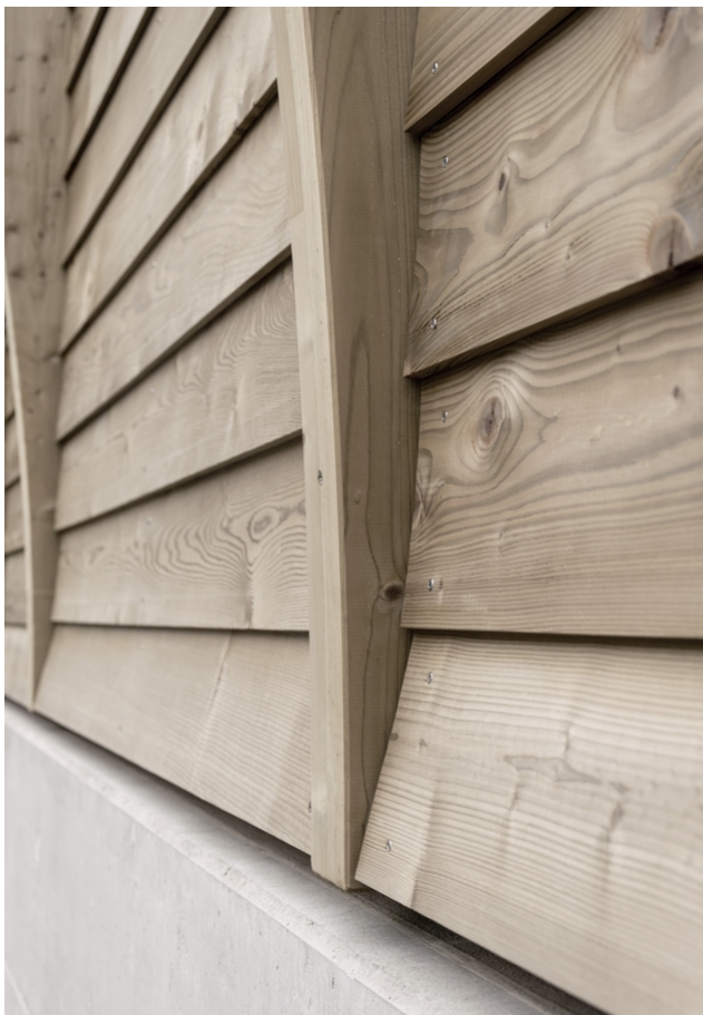
Détail du bardage de la façade
