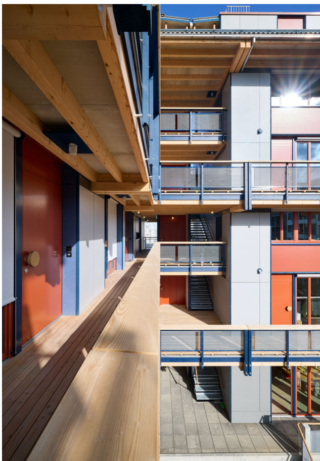
Vue extérieure de l'arcade
