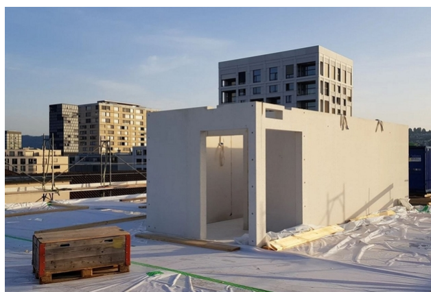
Cage d'escalier en cours de construction
