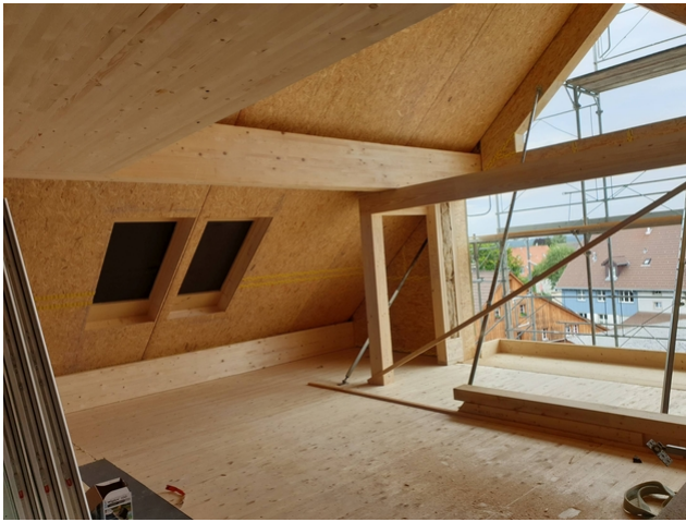
Phase de construction du grenier
