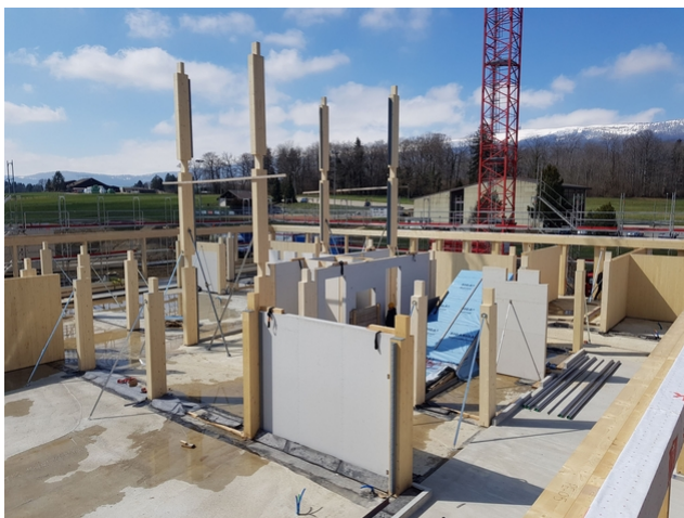
En cours de montage du rez-de-chaussée.
