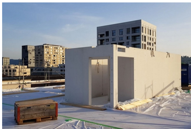
Cage d'escalier en construction
