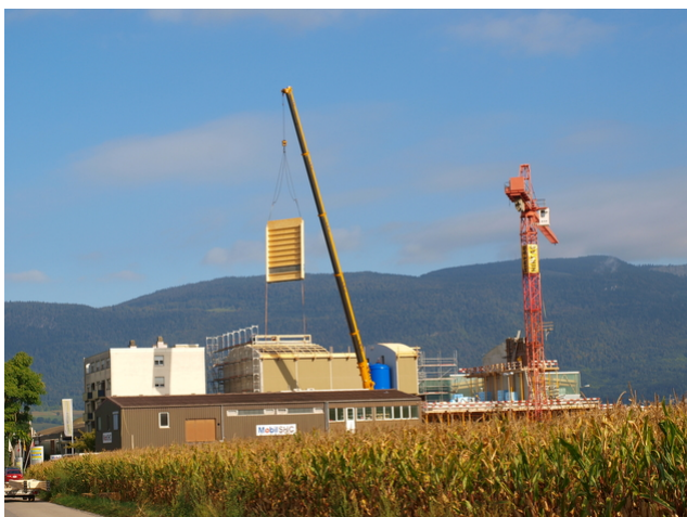
Montage des murs extérieurs
