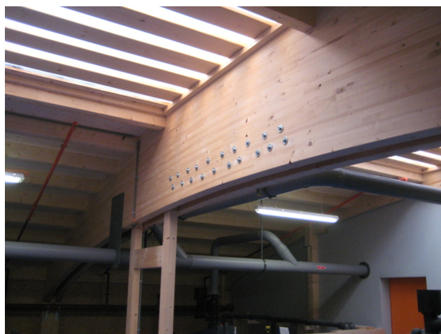
Assemblage de coques de toit
