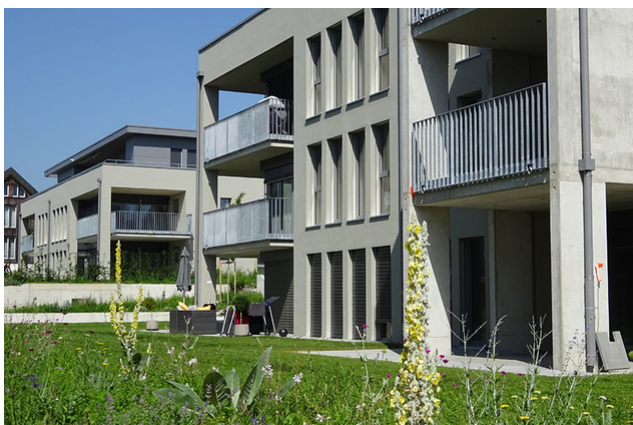
Vue extérieure du lotissement terminé
