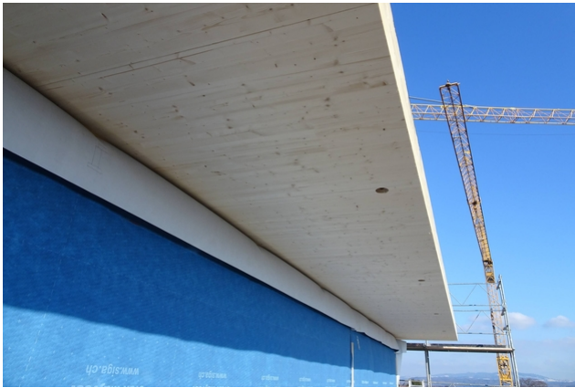
Sous-face de l'avant-toit
