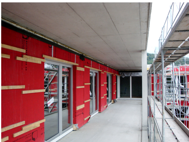
Arcades en cours de construction
