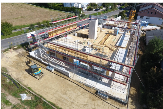
Cage d'ascenseur en CLT
