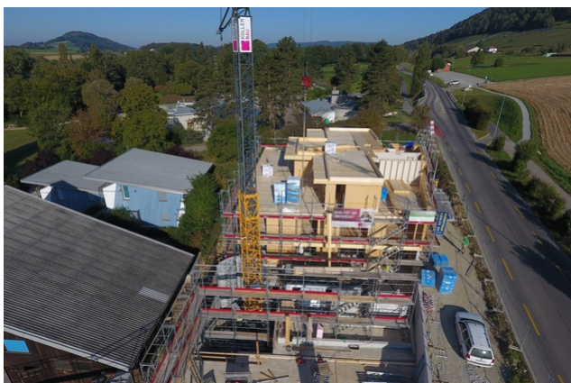
La construction en bois est érigée
