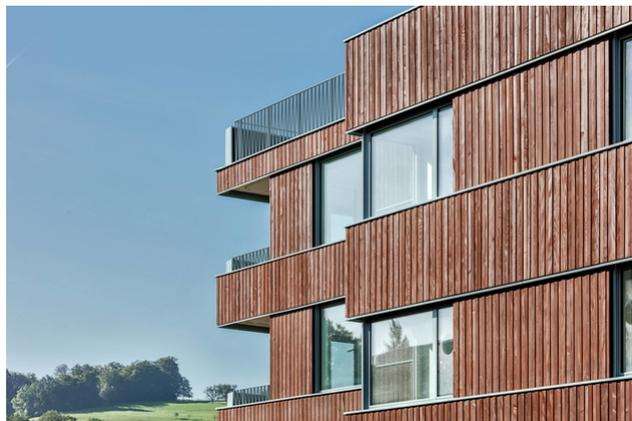
La façade légère en bois a été accrochée devant la construction massive en béton armé. La façade en bois, avec des tabliers en tôle sophistiqués aux géométries complexes, constitue l'enveloppe extérieure de ce lotissement.
