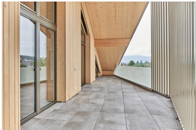
Un bâtiment en bois comprenant douze appartements et un magasin de village a été construit au centre du village de Gretzenbach, dans le canton de Soleure. Les balcons dépassent de plus de 3,5 mètres, et ce sans aucun pilier gênant. Une construction ingénieuse et suspendue le permet.
