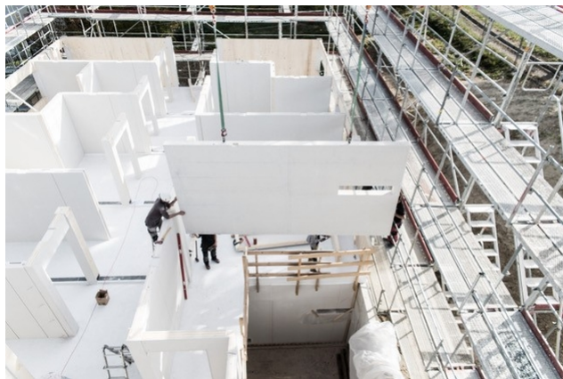
Montage des cloisons intérieures formant compartiment coupe-feu
