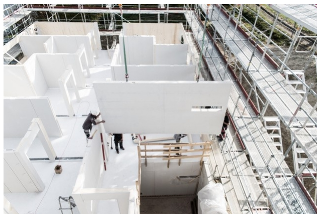
Montage des cloisons intérieures formant compartiment coupe-feu
