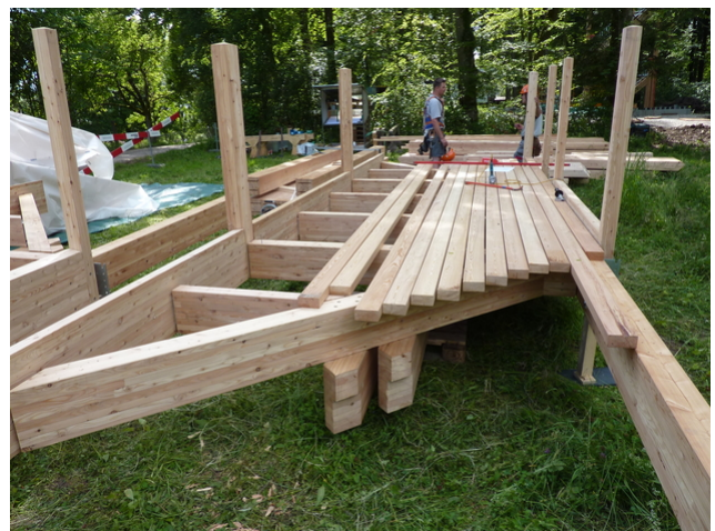
Assemblage de la tour
