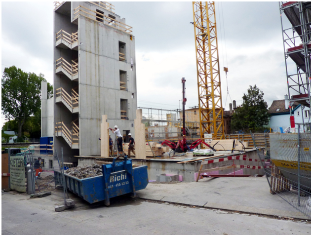
Début du montage des piliers CE
