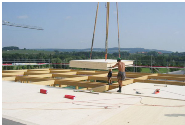
Montage d'éléments de toiture
