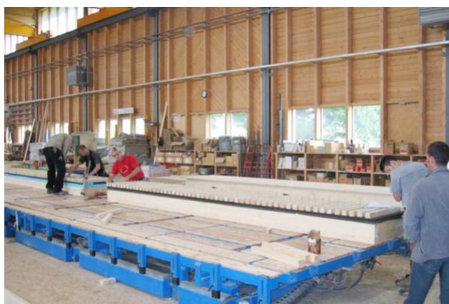
Fabrication d'éléments de toiture
