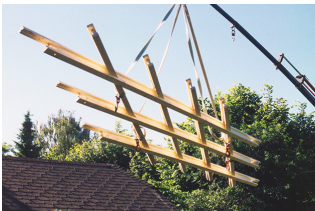
Déchargement de la grille de support
