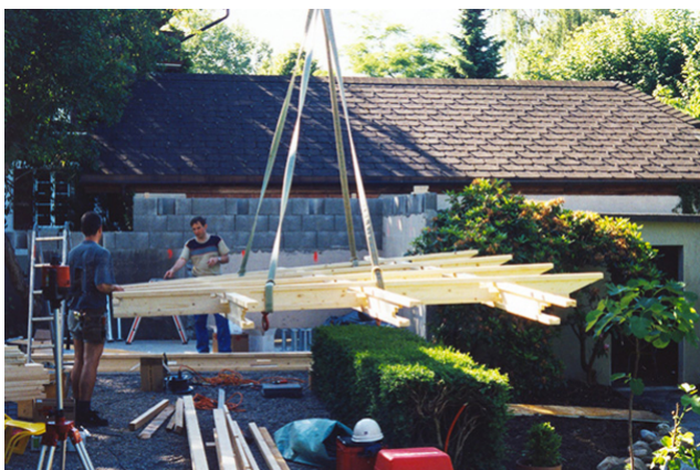
Levage de la grille de support
