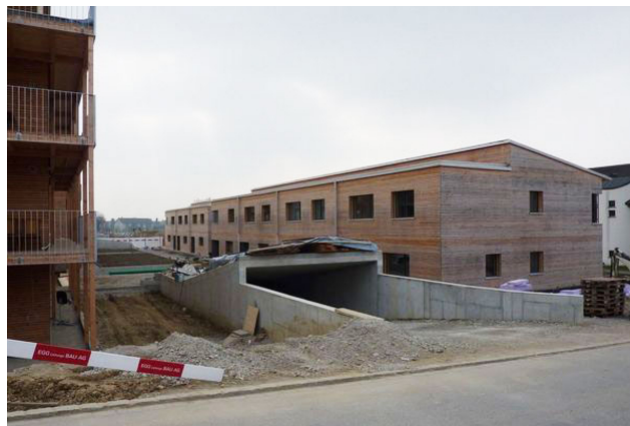
Entrée du parking souterrain
