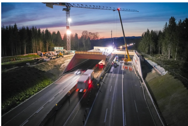
Travaux de montage avec circulation sur une seule voie
