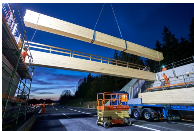
...et sont posés en une seule pièce sur les fondations en béton.
