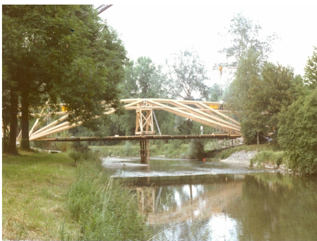
La nouvelle construction
