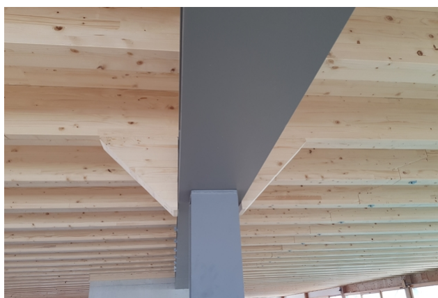
Combinaison de la structure porteuse métallique et de la construction bois
