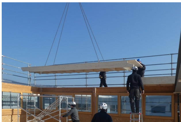
Pose d'un élément de toiture
