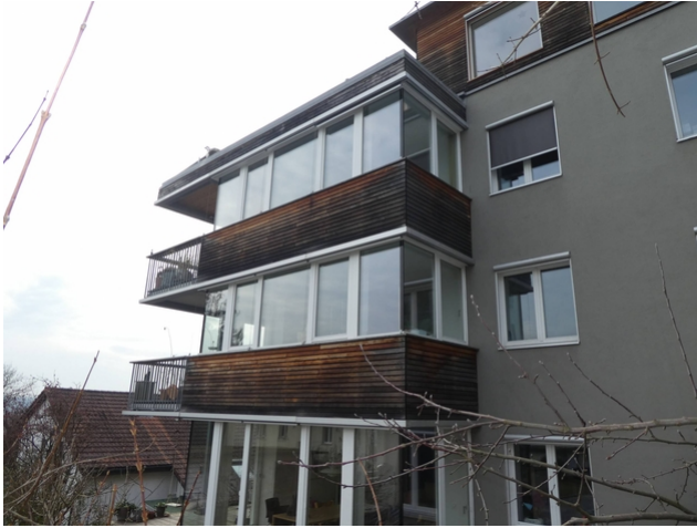
Façade après 10 ans
