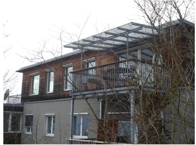
Façade après 10 ans
