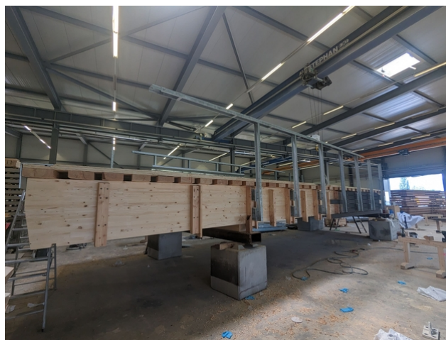
Préfabrication du pont dans les Ateliers de JPF-Ducret.
