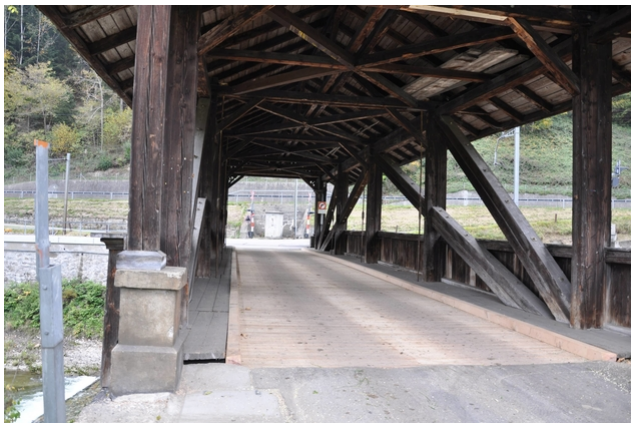
Nouvelle chaussée en planches de chêne aérées
