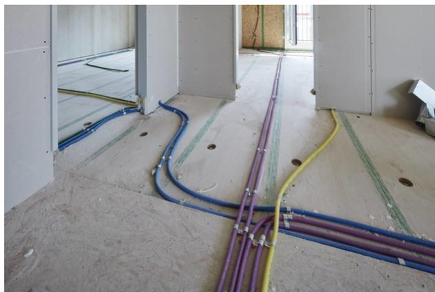
Une construction en bois n'est une véritable construction en bois que si elle peut se passer de béton. C'est pourquoi les planchers mixtes bois-béton font déjà partie du passé chez nous. En lieu et place, nous utilisons des remblais de gravillons liés élastiquement.
