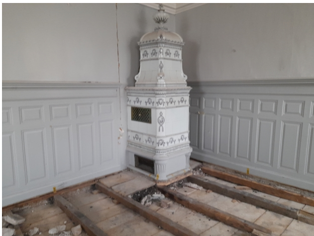
Dalle d'étage avant amélioration
