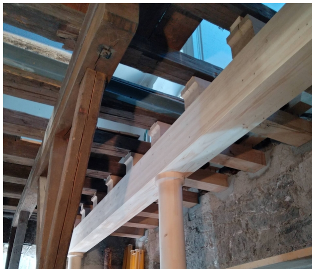
Mesures d'assainissement dans la cave à vin
