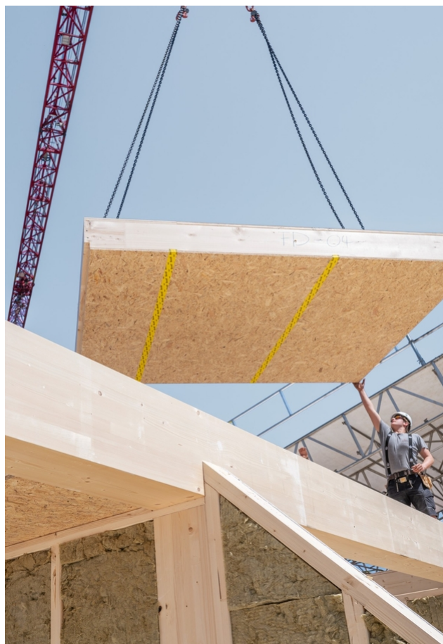
Mise en place d'éléments de plancher
