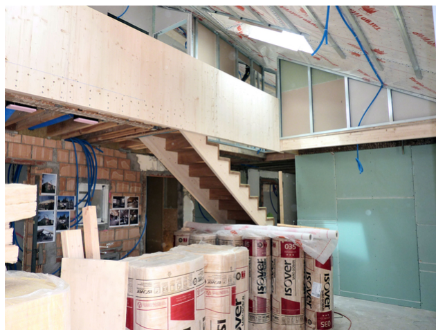
Cuisine pendant la rénovation
