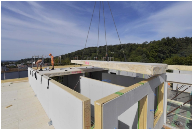
Travaux de redressement avec la grue
