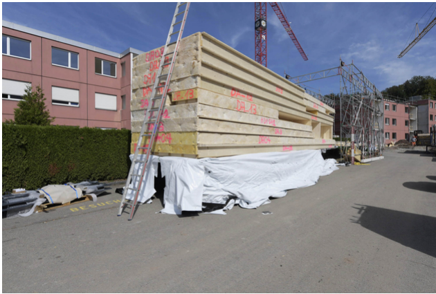
Livraison des éléments en bois préfabriqués
