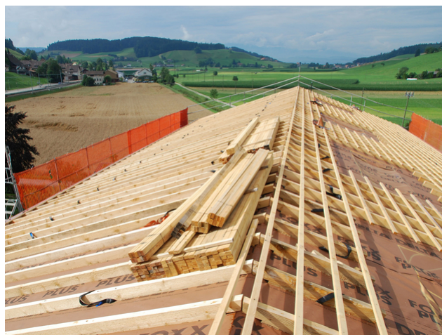
Vue du toit
