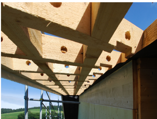
Construction de l'auvent
