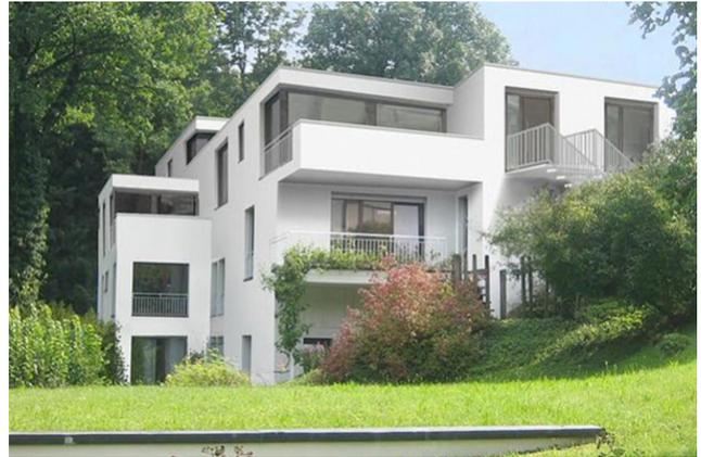
Sur la maison existante de deux familles située dans un cadre naturel, une surélévation d'un à deux étages a permis de créer de nouveaux espaces de vie en ossature bois. La construction du toit plat sans poutres et les façades vitrées à hauteur de plafond sont particulières.
