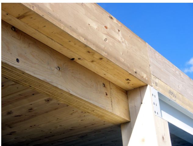
Linteau de fenêtre
