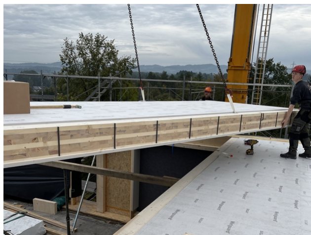
Dalle CLT préparée sur le côté longitudinal lors du montage, avant le coulage des joints TS3.
