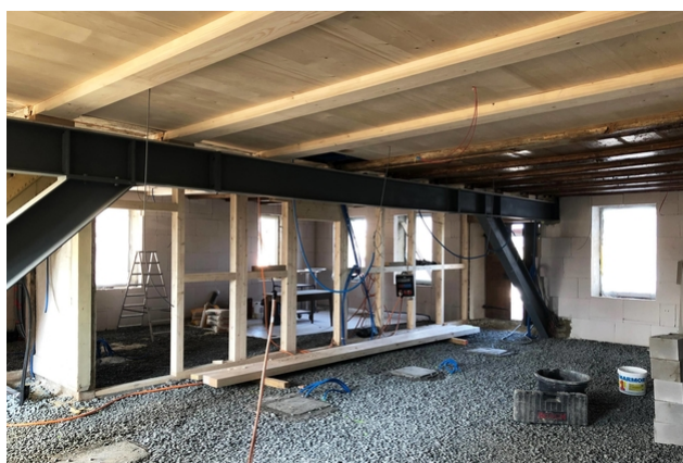
Poutrelles en acier dans un bâtiment ancien
