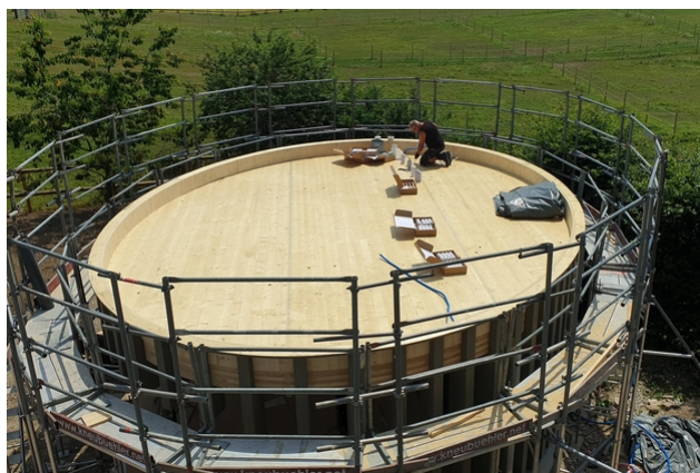
Scellement du joint TS3
