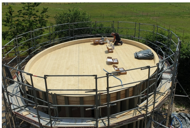
Scellement du joint TS3
