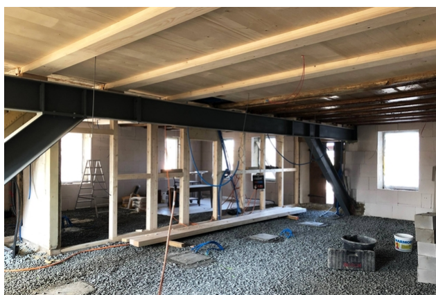
Poutrelles en acier dans un bâtiment ancien
